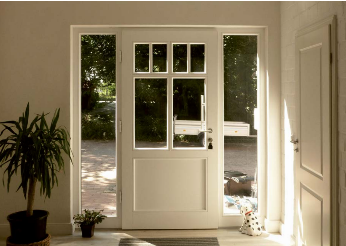
Projekt: Umbau eines Fachwerkhauses Ausführung: Haustür mit motorischer Öffnung und Fingerscanner Besonderheiten: Historische Profilierungen Bundesland: Nordrhein-Westfalen
