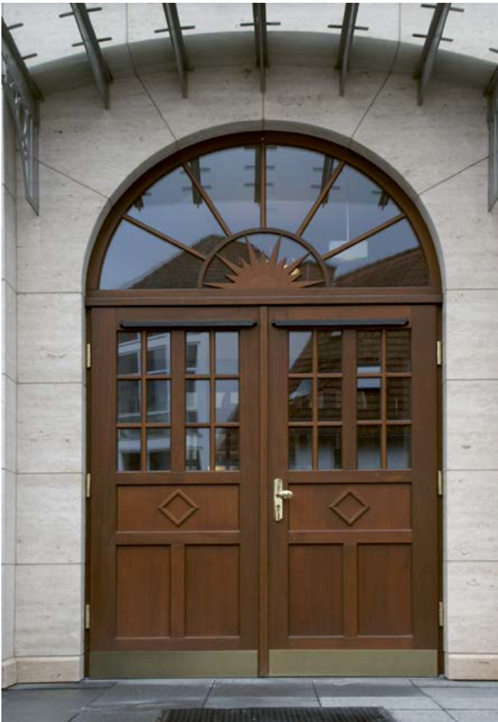
Projekt: Eingangsfassade eines Mehrfamilienhauses Ausführung: Haustür in Rahmenbauweise für Pfosten-Riegel-Konstruktion Besonderheiten: Profilierung Bundesland: Nordrhein-Westfalen
