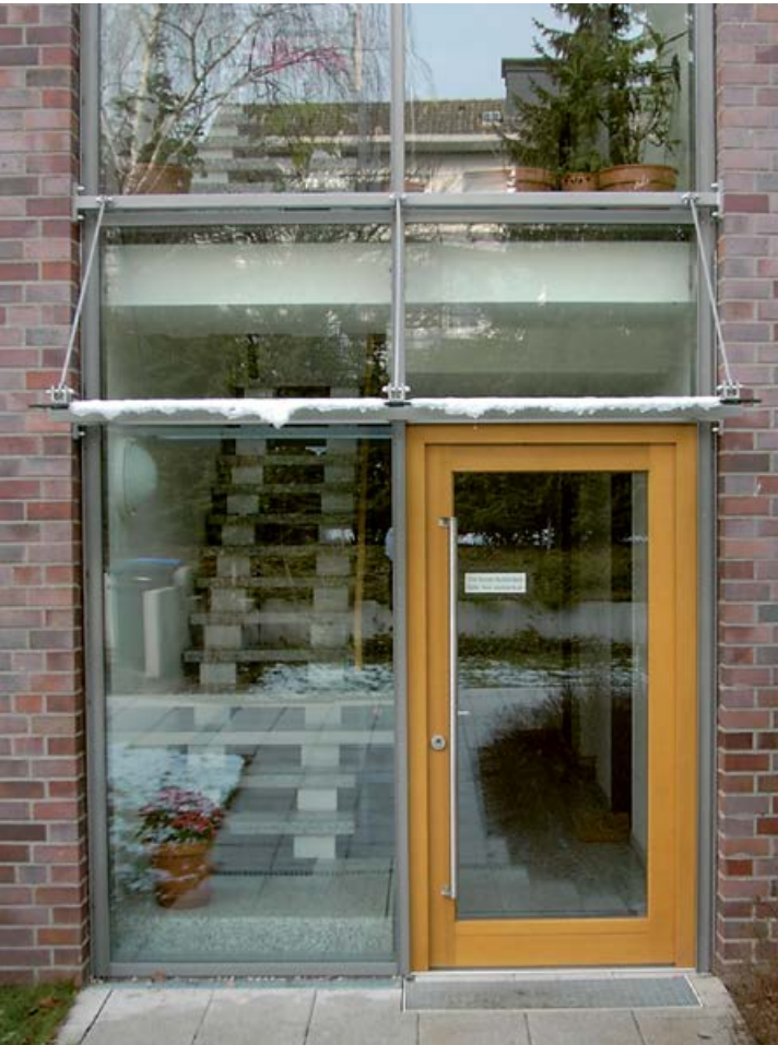
Projekt: Eingangsfassade eines Mehrfamilienhauses Ausführung: Haustür in Rahmenbauweise für Pfosten-Riegel-Konstruktion Besonderheiten: Profilierung Bundesland: Nordrhein-Westfalen
