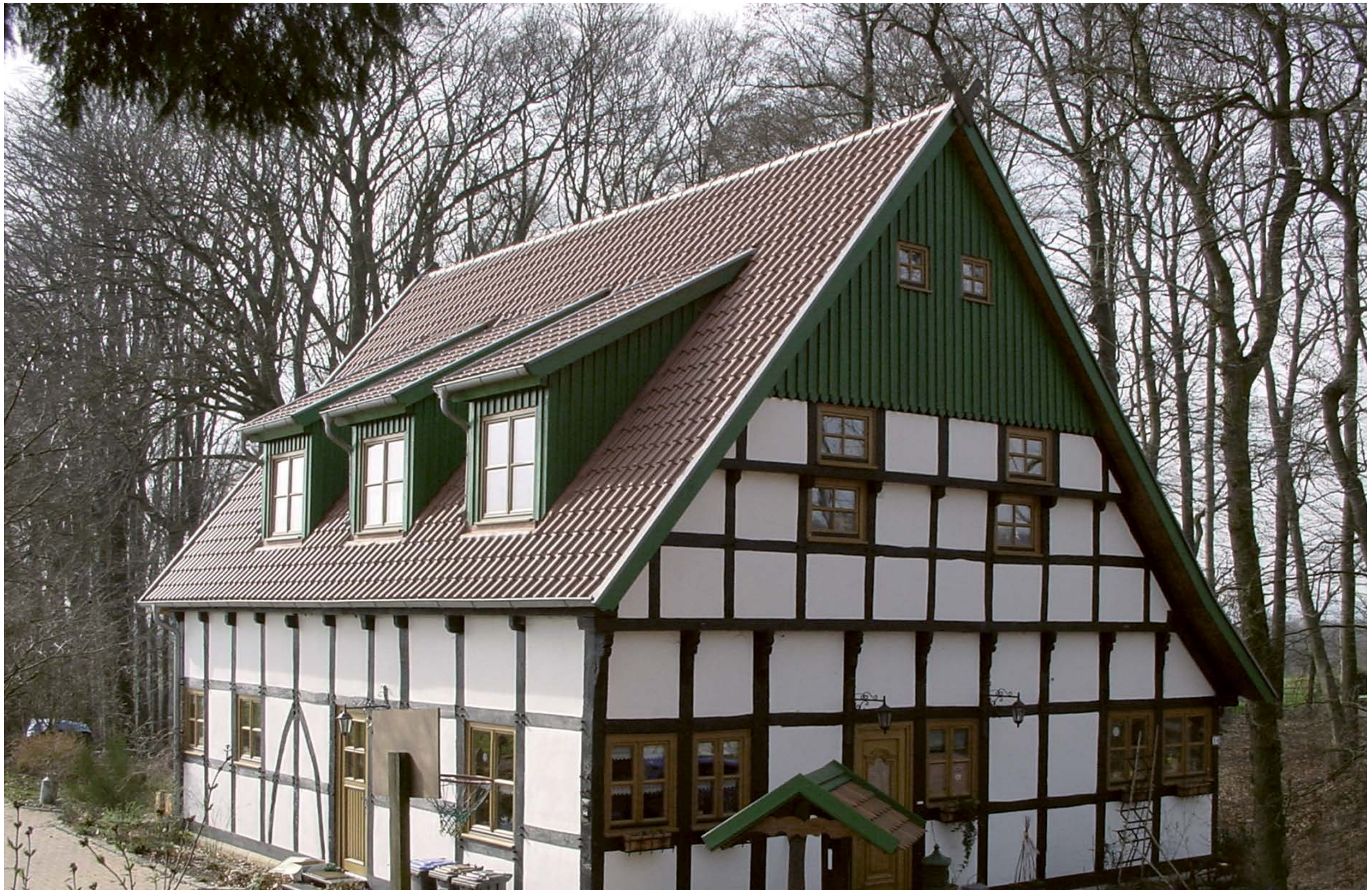
Projekt: Sanierung eines Fachwerkhouses Ausführung: Holzfenster System IV 68 aus Eiche Besonderheiten: Profilierung gemäß Denkmalpflege Bundesland: Nordrhein-Westfalen
